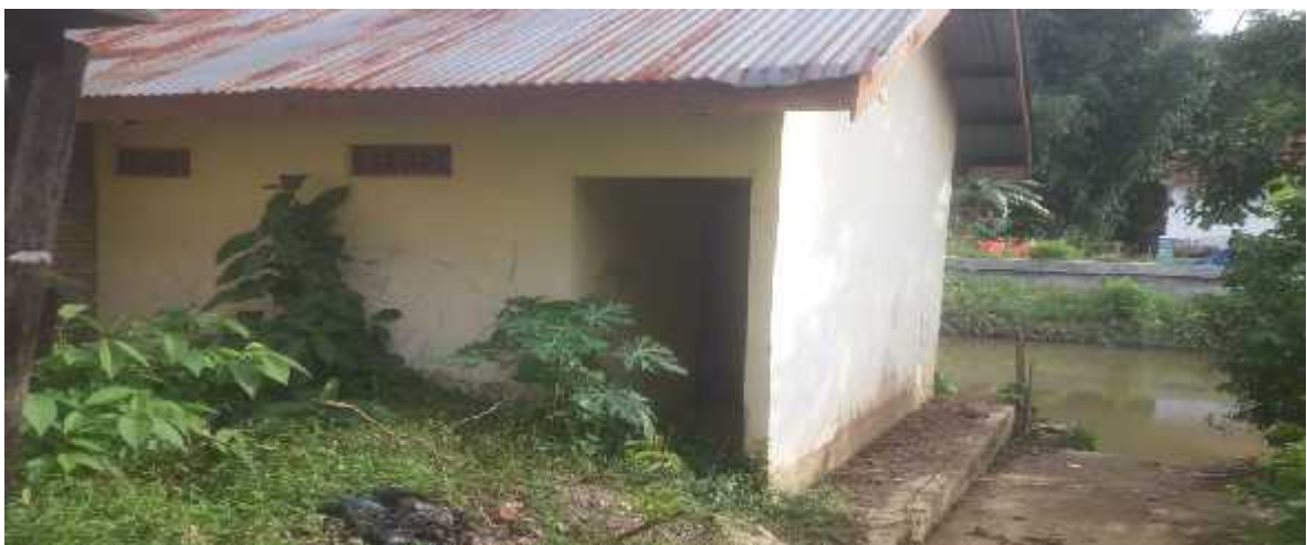
MCK dibangun Th. 2015, Lokasi Desa Koto Panap Kecamatan Tanah Kampung
