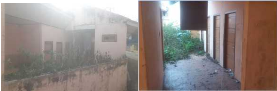
MCK dibangun Th. 2014, Lokasi Desa Koto Pudung Kecamatan Tanah Kampung
