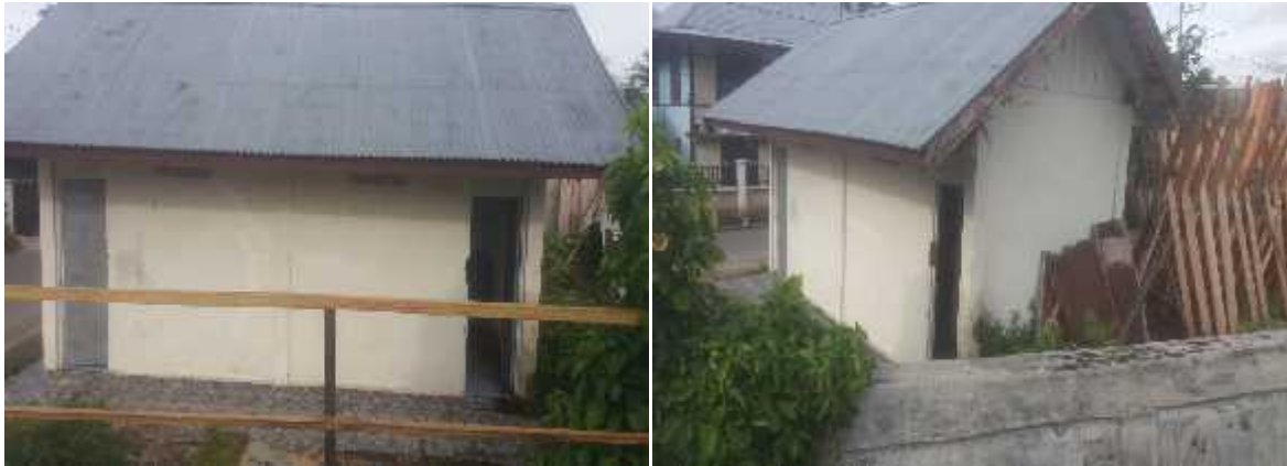
MCK dibangun Th. 2014, Lokasi Desa Koto Tuo Kec. Tanah Kampung
