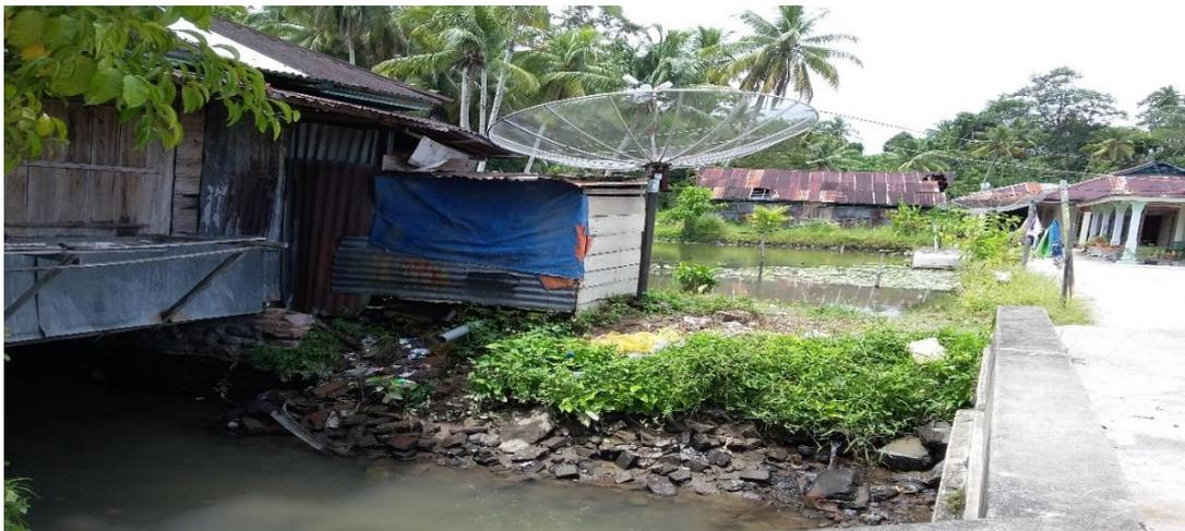
➤ Dinding saluran sudah amblas dan adanya bangunan di atas saluran irigasi. Runtuhnya dinding saluran dapat diakibatkan karena pengalihan aliran air dengan cara membobol saluran untuk kepentingan pribadi, yang lama kelamaan menyebabkan keruntuhan pada dinding saluran
