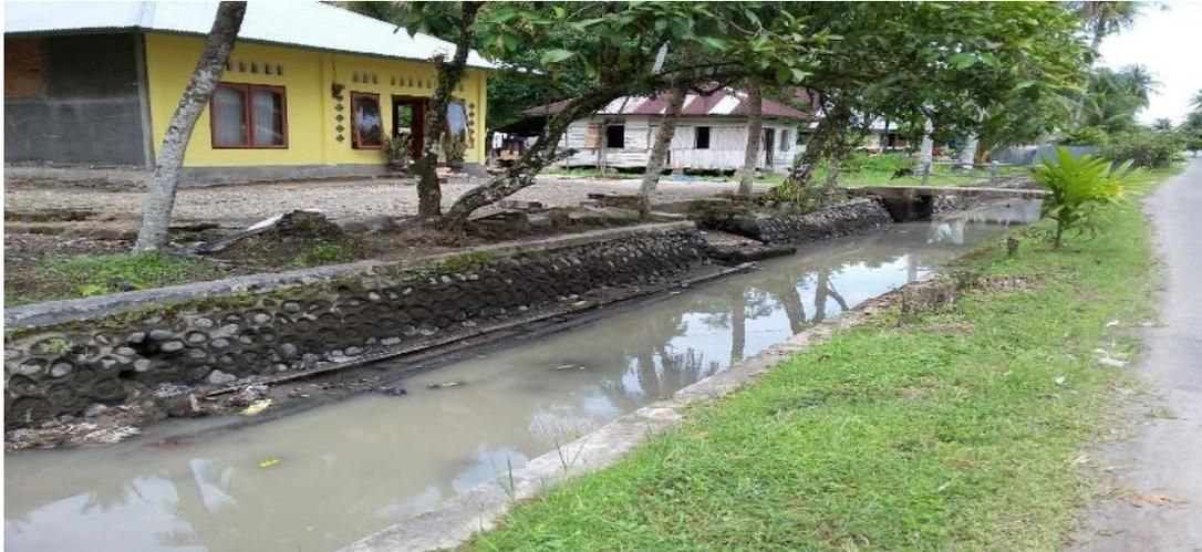
Kerusakan pada dinding saluran, dimana pemasangan batu kali sudah terbongkar sebagian. Kondisi lantai saluran masih perkerasan tanah
