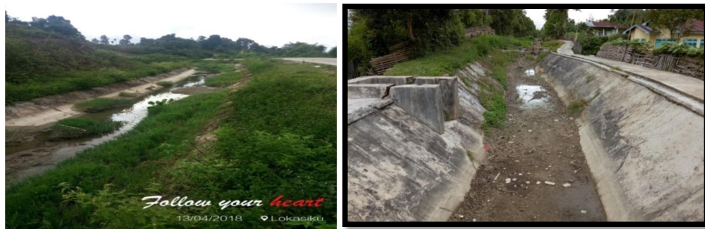
Gambar 1.1 Kondisi Jaringan irigasi Siulak Deras tahun 2018
