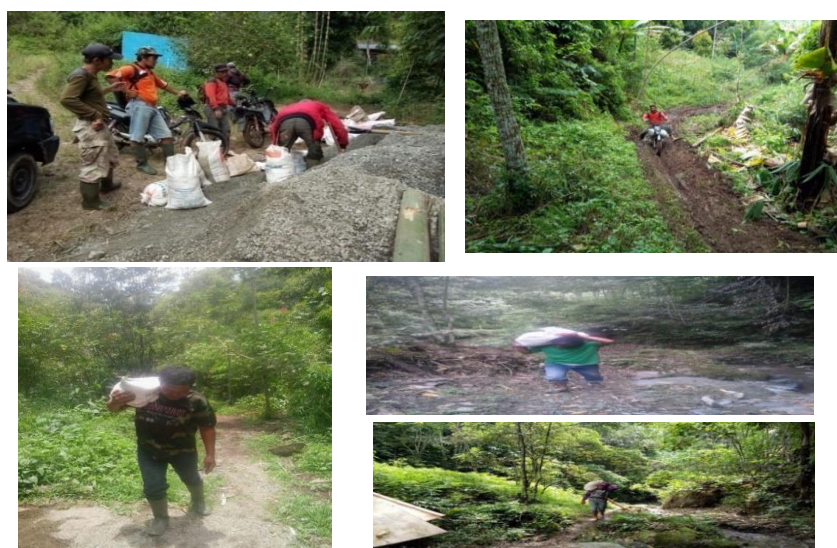
Gambar 1.1. Proses mengangkut material menuju lokasi proyek dengan menggunakan tenaga manusia
