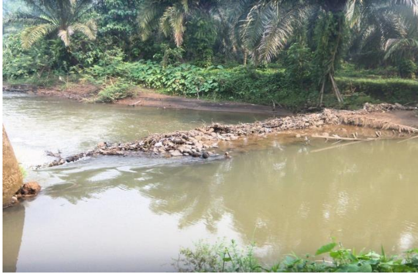
Gambar 1. 1 Kondisi Bendung (Sumber : Dokumentasi Lapangan)
