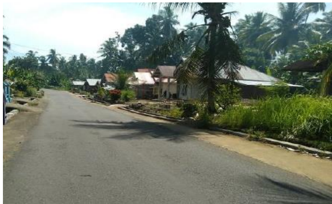
Gambar 1.2 Ruas Jalan Lubuk Basung – Sungai Limau (P.072)
