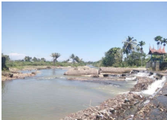
Gambar 1.2 kondisi bendung saat ini ( Sumber : Dokumentasi Lapangan)
