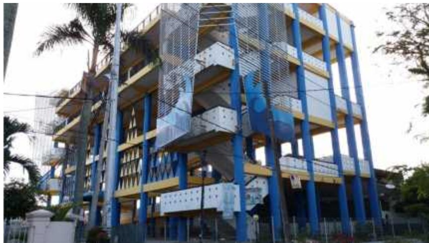
Gambar 1.3 (Tampak Gedung Shelter Ulak Karang Kota Padang)
