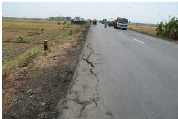
Gambar 2.10 Edge Cracking
