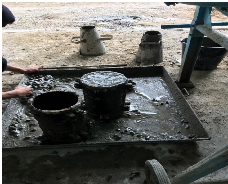
Lampiran.30 Proses pemasukan beton pada bekisting
