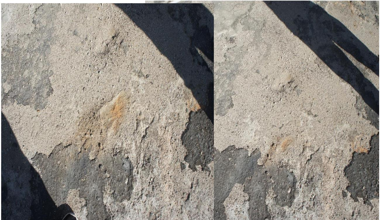
Gambar 18. Beton Lantai bagian Atap Keropos
