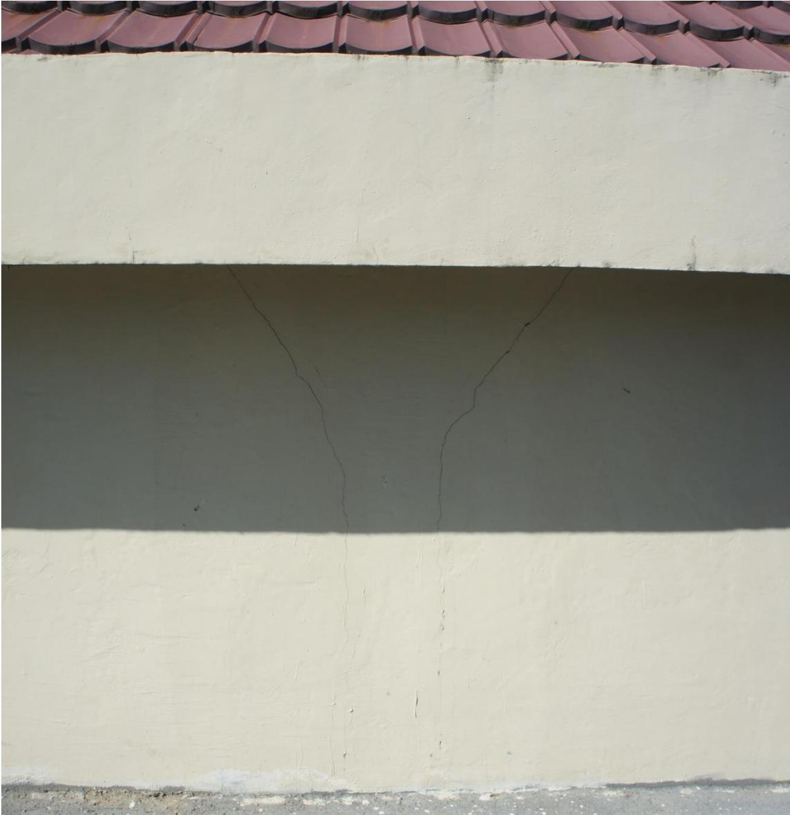
Gambar 20. Pemisahan/retak pada kolom pada bagian atap tidak adanya pengankuran dan beban atap)
