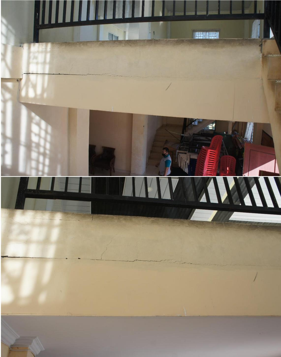
Gambar 14. Retak lentur dan geser yang mengakibatkan terjadi lendutan pada balok
