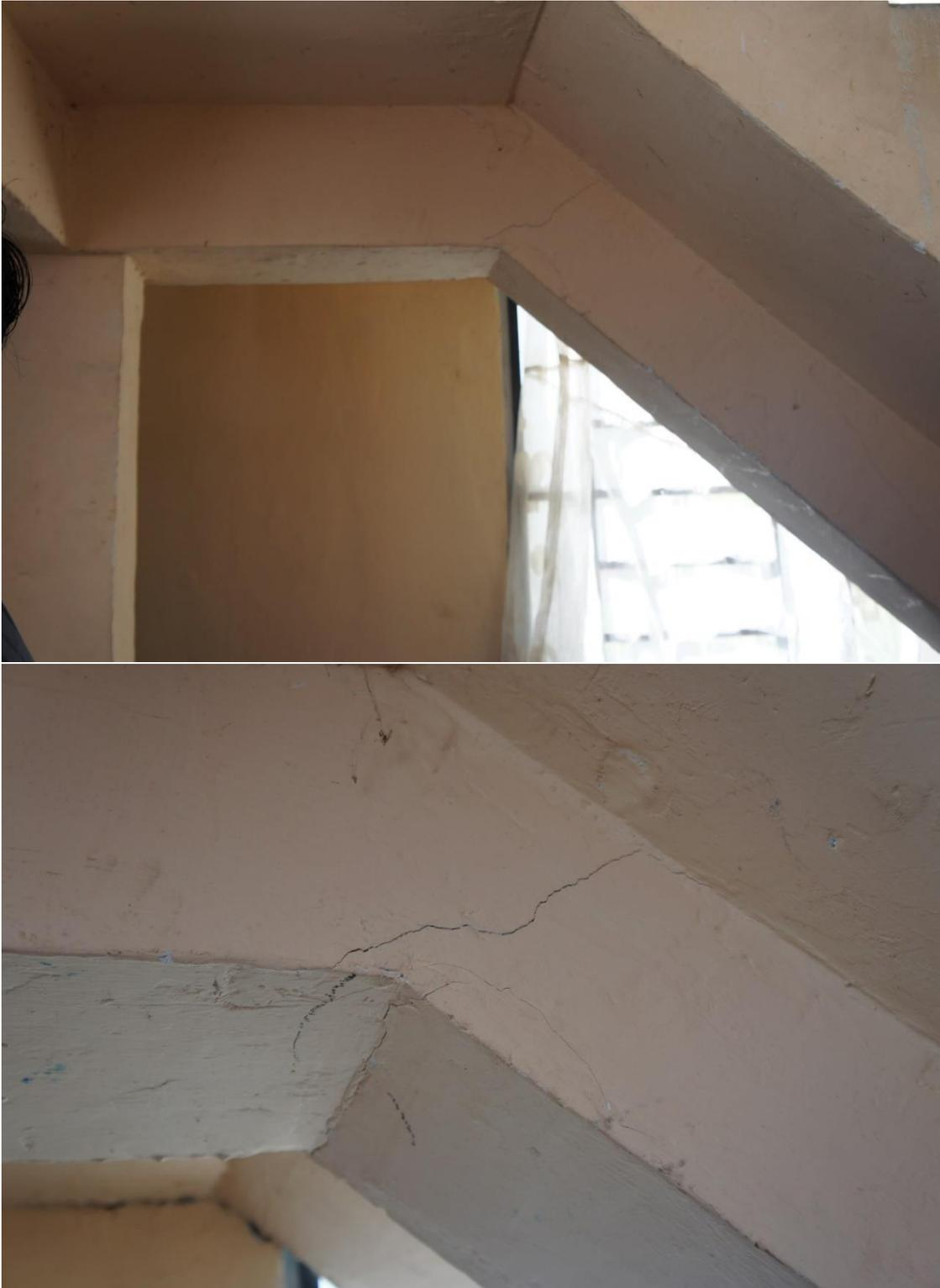
Gambar 21. Retak geser pada ujung balok (sambungan Balok)
