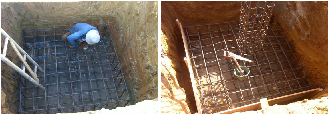
Gambar 1. Pondasi plat setempat pada Gedung Aula Kantor Walikota Sungai Penuh
