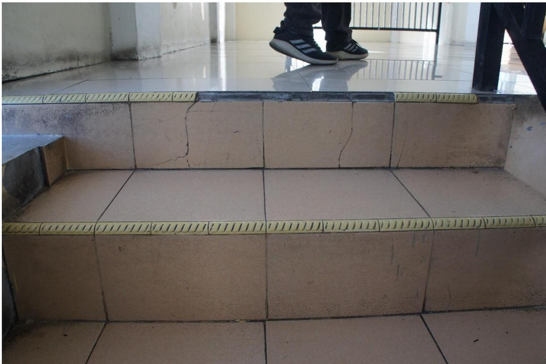
Gambar 16. Retak Lentur dan Geser pada Bagian Balok Lantai Tangga Kiri (berbahaya)
