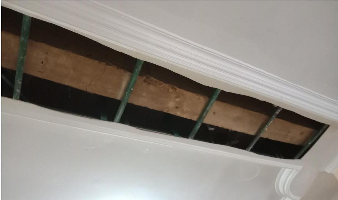
Gambar 17. Retak Lentur dan Geser pada Bagian Balok Lantai 2 bagian tengah
