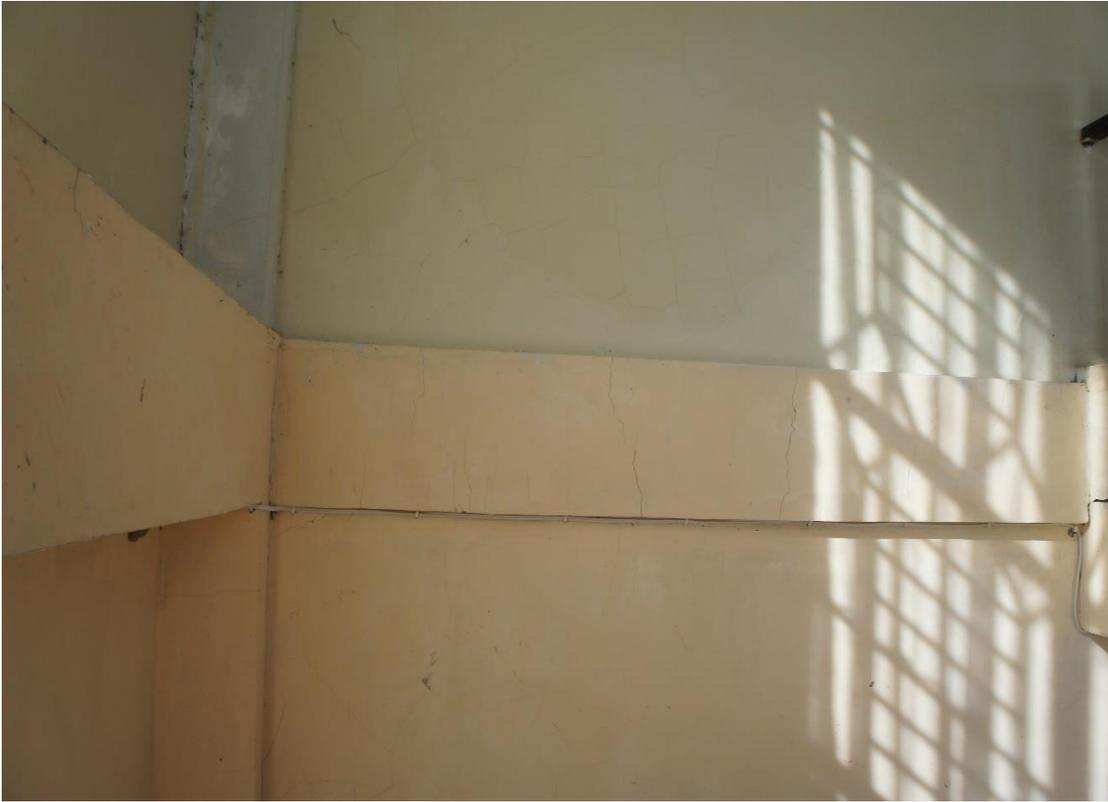
Gambar 13. Retak Lentur dan retak selimut beton pada bagian balok lantai 2 bagian kanan
