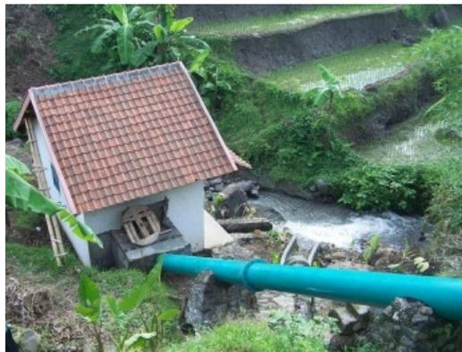
**Gambar 3.12. Pipa Pesat dan *Powerhouse***
