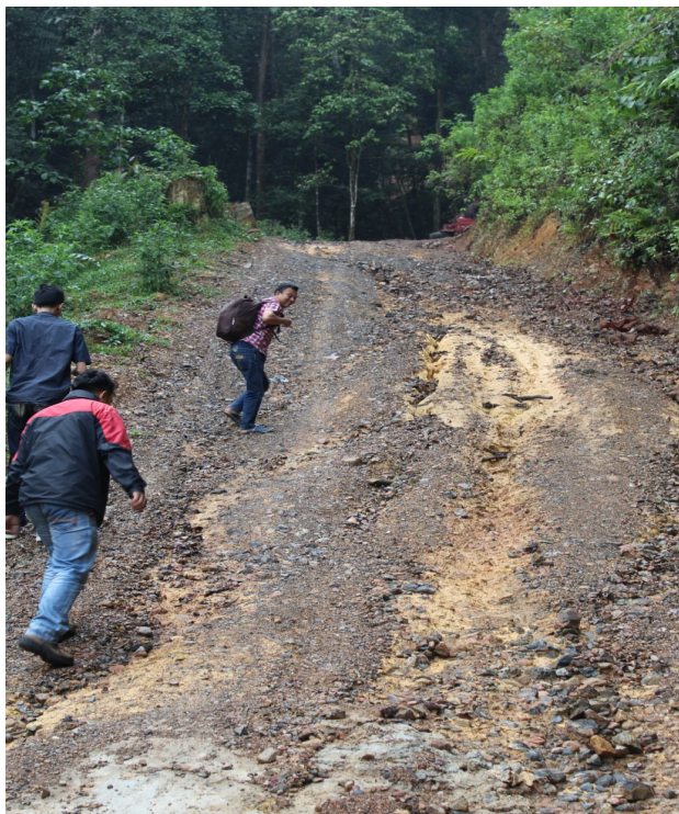
Gambar 3.2 Foto jalan akses dari Nagari Batu Bajanjang ke Nagari Garabak Data
