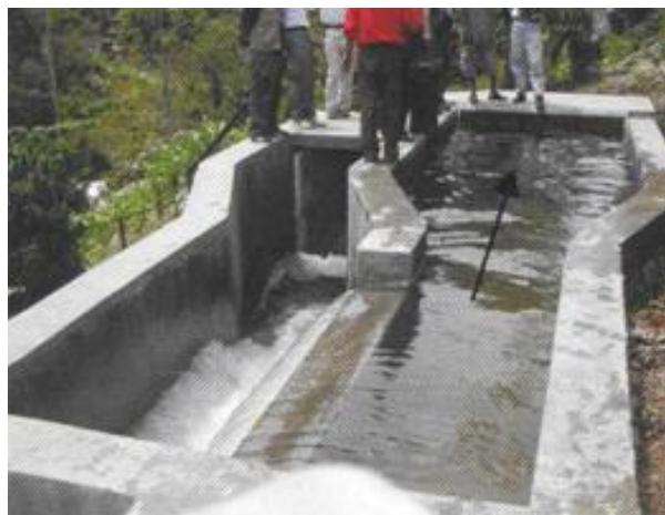
Gambar 2.6 Forebay (bak penenang)
