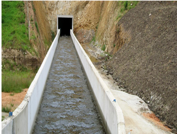
Gambar 2.5 Headrace (saluran pembawa)
