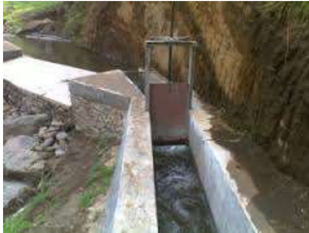
Gambar 2.3 Intake (bangunan pengalih)
