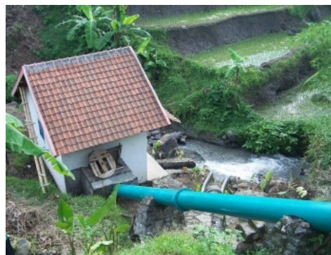
Gambar 2.8 Power house (rumah pembangkit)
