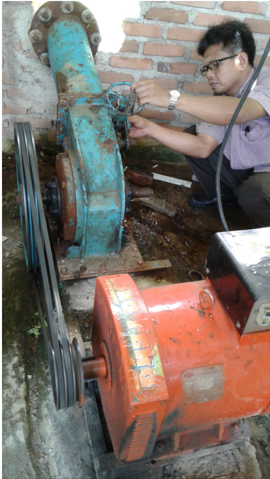
Gambar 5.13. Identifikasi Posisi Pemasangan GLC
