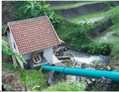
**Gambar 3.12. Pipa Pesat dan Powerhouse**
