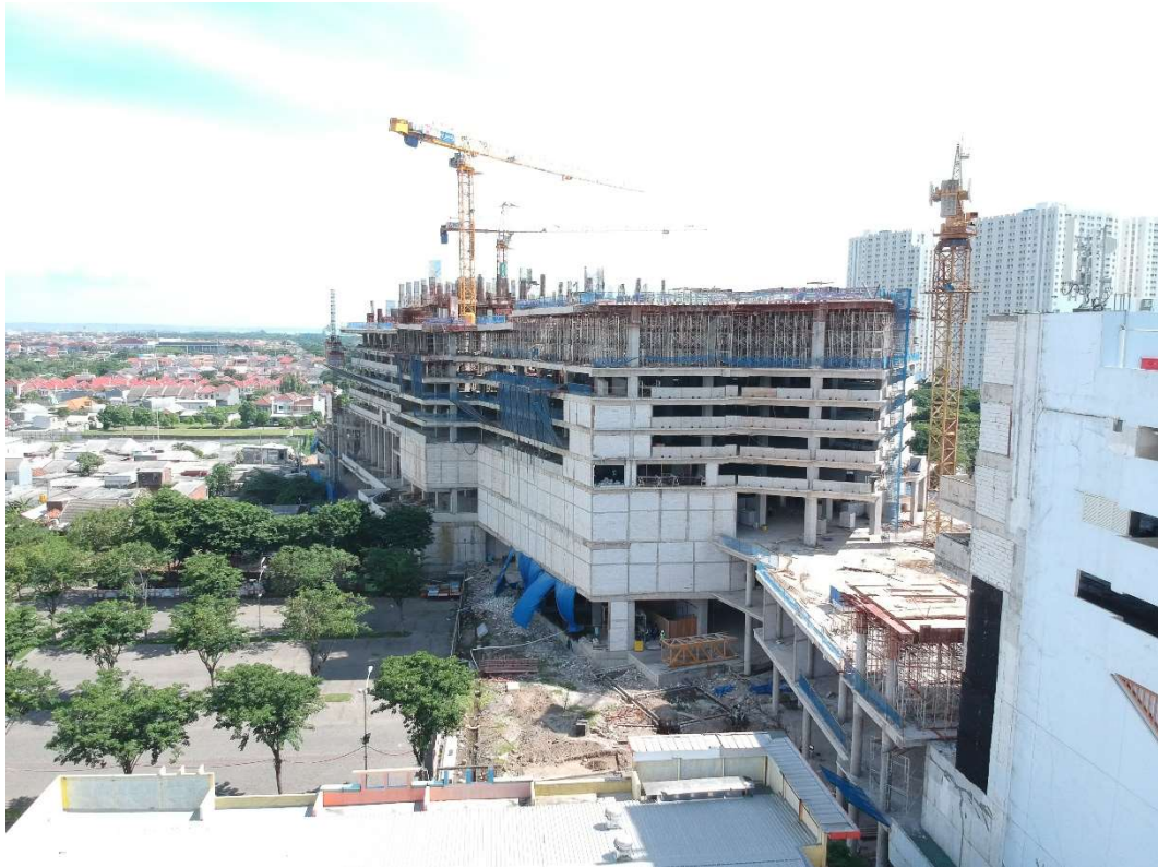
Gambar 2.1 Gambar Pembangunan Proyek East Coast Center 2
