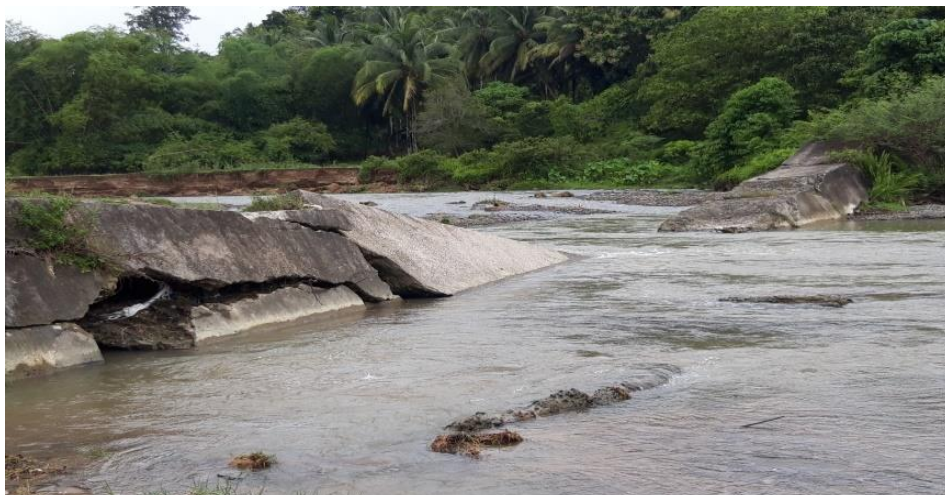
Gambar 1. 2 Kondisi Groundsill di Lapangan (Sumber:Dokumentasi Penulis 2020)
