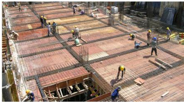
Gambar 2.6 Pemasangan Tulangan Plat dan Balok
