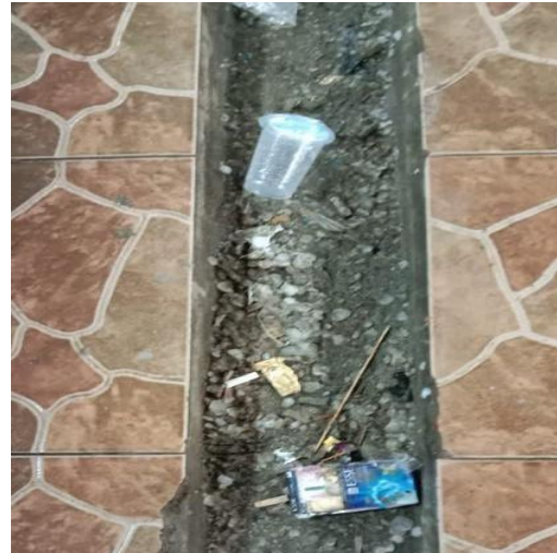
Gambar 14. Saluran Limbah Cair (tersumbat)
