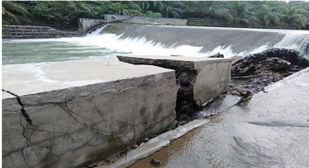
Gambar 1. 1 Bendung Batang Bayang (Sumber : Dokumentasi pribadi)
