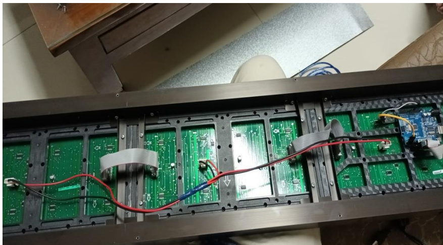
Gambar 32. Pemasangan papan p 10 pada kerangka bingkai papan running text
